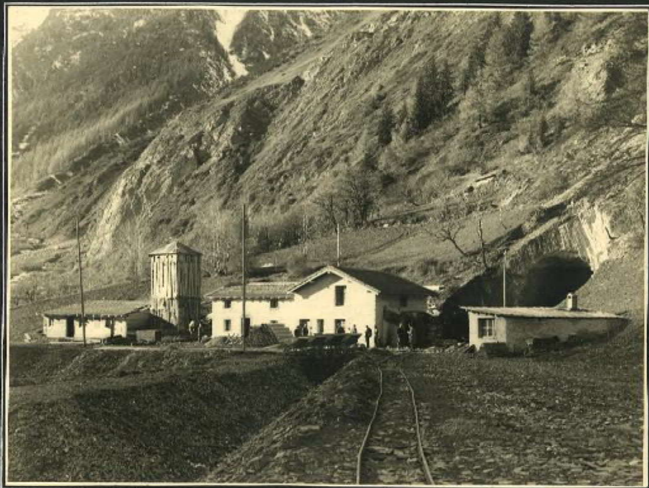
22-11-1946 Cantiere dell'Imbocco Dračovo — Imprese associate: Gieroz e Berteli
