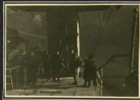
Interno Stazione superiore
