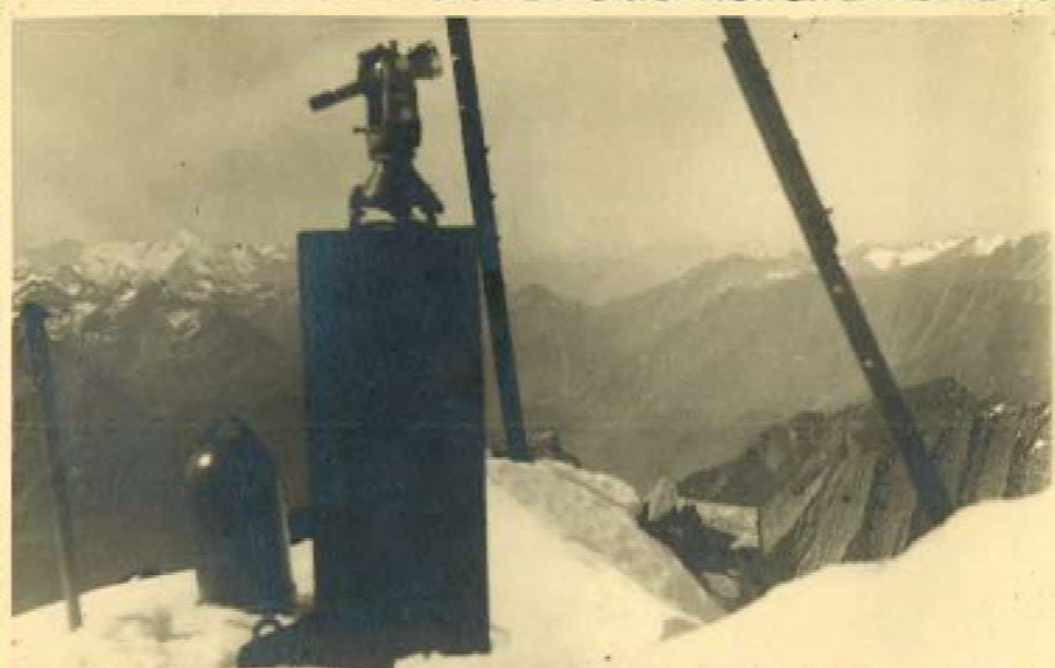
TRIANGOLAZIONE TRAFORO M. BIANCO - LA GRANDE ROCHERE (m. 3326) Vertice di 1° ordine della rete Geodetica Italiana. TEODOLITE WILD T.3 - Settembre 1946 - GEOM. PIERO ALARIA.
