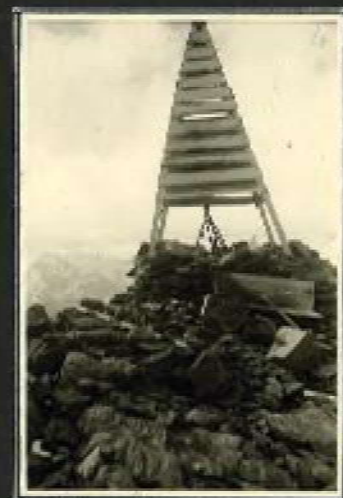
Segnale trigonometrico dell'Istituto Geografico Militare (Agosto 1951) Il pilastro a terra è andato distrutto a causa di un fulmine. Rimane il basamento per l'altezza di 30 cm.
