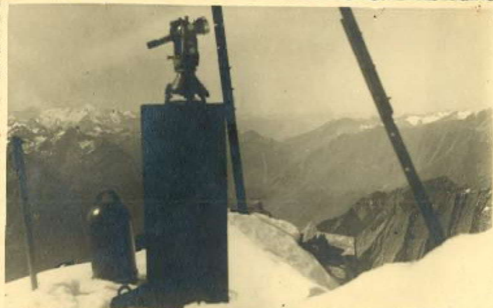
TRIANGOLAZIONE TRAPERO M. BIANCO - LA GRANDE ROCHE (m. 3326) Vertice di 1° ordine della rete Geodetica Italiana. THEODOLITE WILD T.3 - Settembre 1946 - GEOM. PIERO ALARIA.
