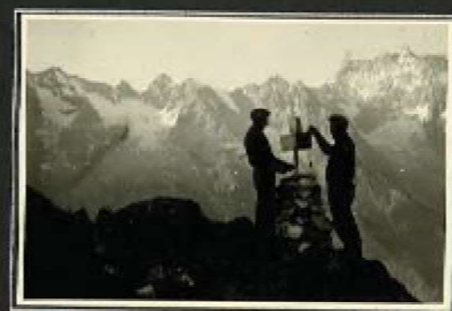
Collocamento del segnale di traguardo
