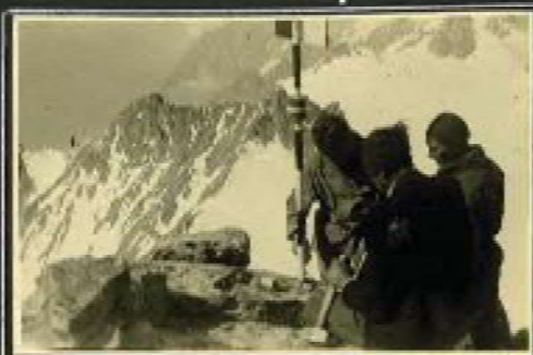
Posa del segnale di traguardo
