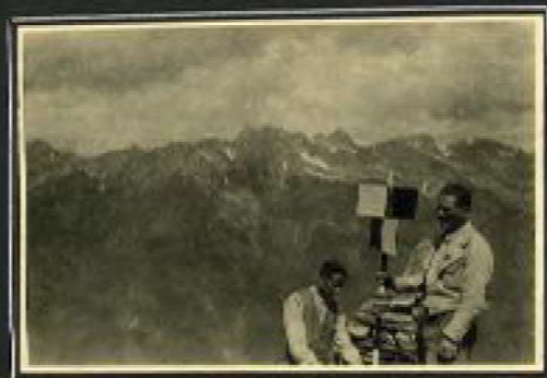
Costruzione del segnale di traguardo 1-8-46
