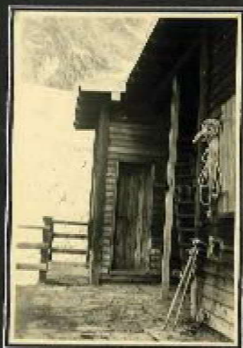
Ingresso al Rifugio
