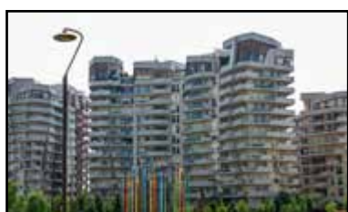
L'impianto elettrico condominiale, pag. 18
