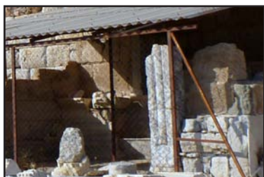
Coperture in Eternit amianto. Obblighi di controllo e manutenzione, pag. 27
